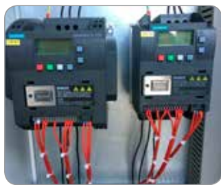
Inverter Siemens SINAMICS V20 per controllo velocità tavola e testa
